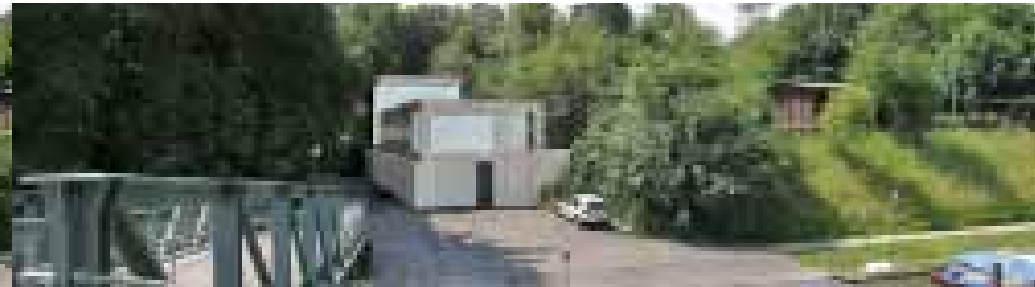
Das neue Bootshaus, ab 2012
